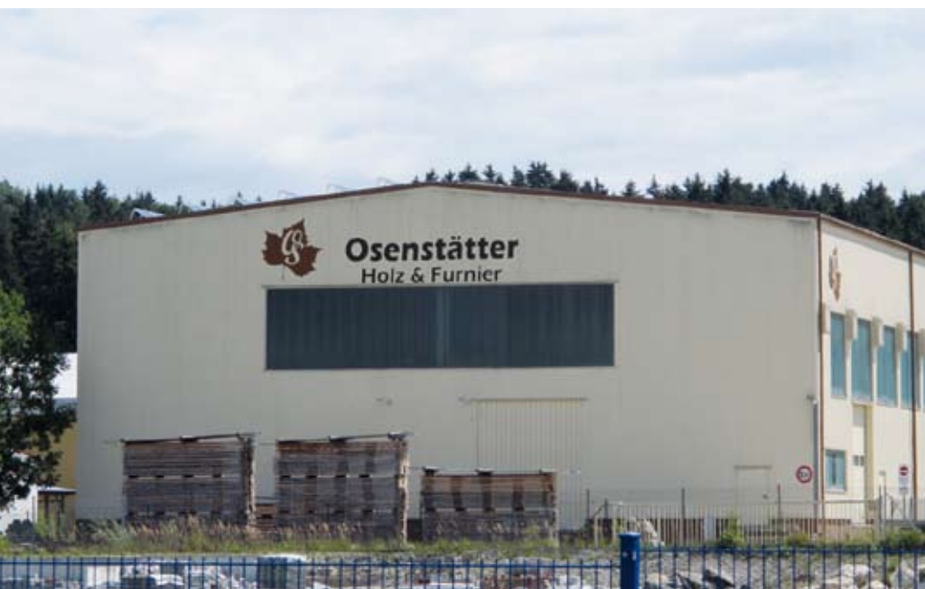
Das Firmengelände liegt im Gewerbegebiet von Schongau. Die Betriebsfläche wuchs seit der Firmengründung von 4000 m 2 auf derzeit 60000 m 2 an
